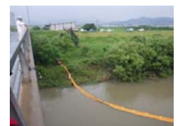
(河川へのオイルフェンス設置)
