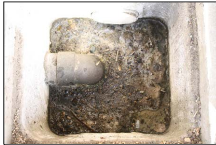
改修工事前(固形物堆積)
