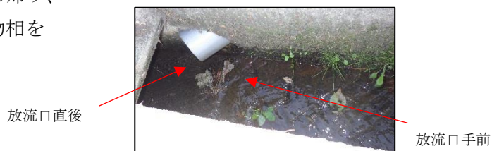
図2. 浄化槽からの放流管の出口
