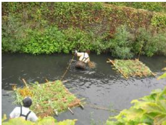
植栽イカダ設置
